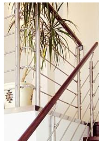
Rundrohrstütze verzinkt Montage auf der Stufe Stäbe mitlaufend
